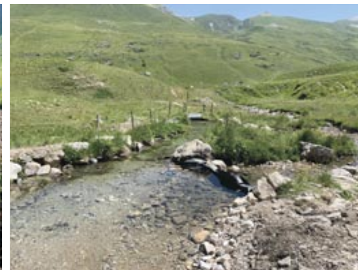
Lavori di ripristino della presa (foto G. Aimo)
