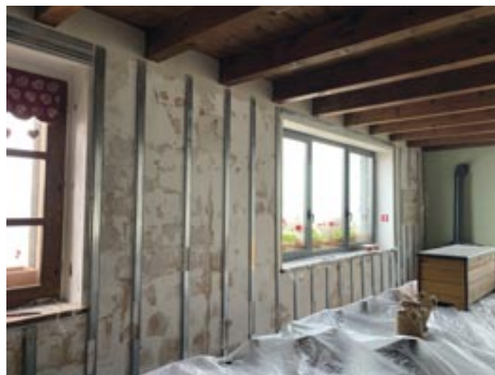
Posa pannelli Aquapanel salone (foto G. Aimo)
