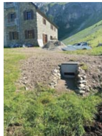
Lavori esterno scarico vespaio (foto G. Aimo)
